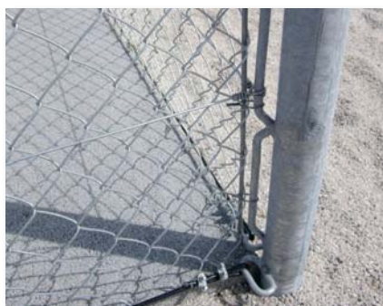
Poteau d'angle avec barre de maintien soudée.
